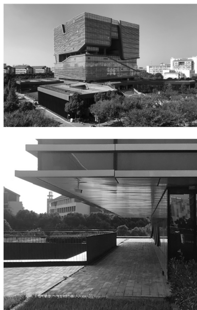
图1 西浦中心楼东南向全景及架空平台
